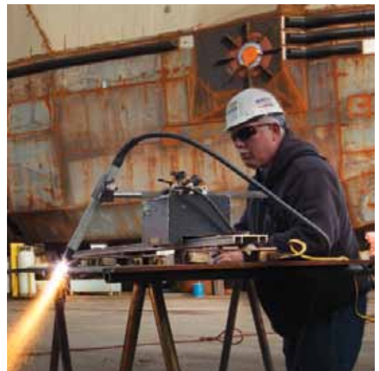
Schienenschneiden und Fugenhobeln
