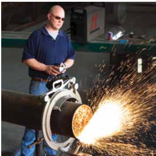
Rohr- und Fasenschneiden
